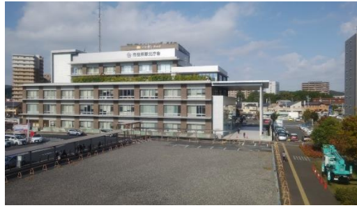
市役所駅北庁舎
